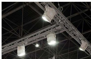
Beleuchtungssystem: Punkttraversen mit HQI Strahlern
