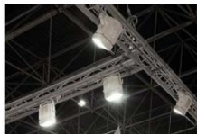
Beleuchtungssystem: Punktraversen mit HOI Strahlern
