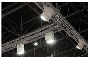
Beleuchtungssystem: Punkttraversen mit HQI Strahlern
